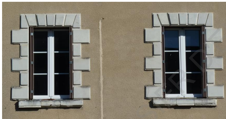
Figure 20 : Moellons en contour de fenêtres sur une maison à Parçay-les-Pins (source : EVEN Conseil).
