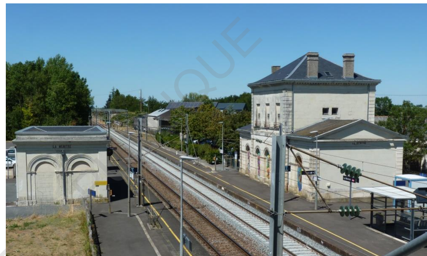
Figure 31 : Gare et voie ferrée de La Méniltré (source : EVEN Conseil).
