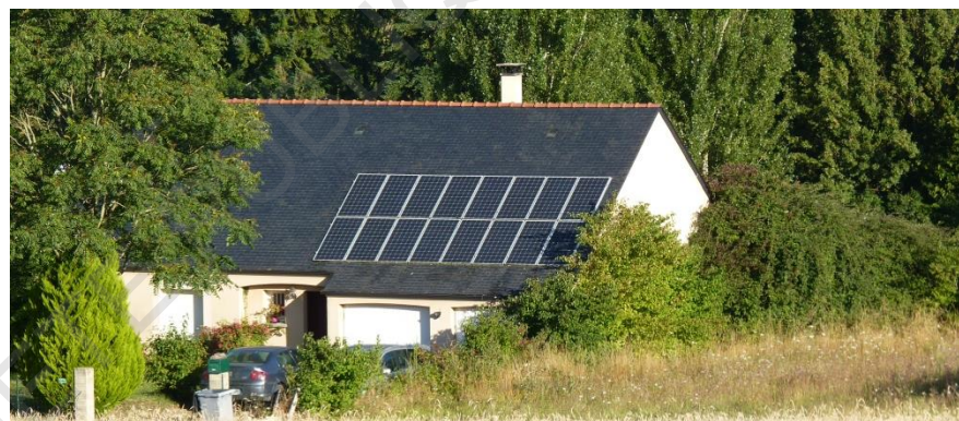
Figure 68 : Installation photovoltaïque sur toiture à Échemiré (source : EVEN Conseil).
