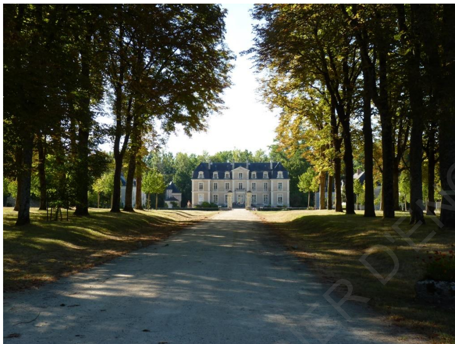
Figure 14 : Château et parc de Lathan à Breil, site classé (source : EVEN Conseil).
