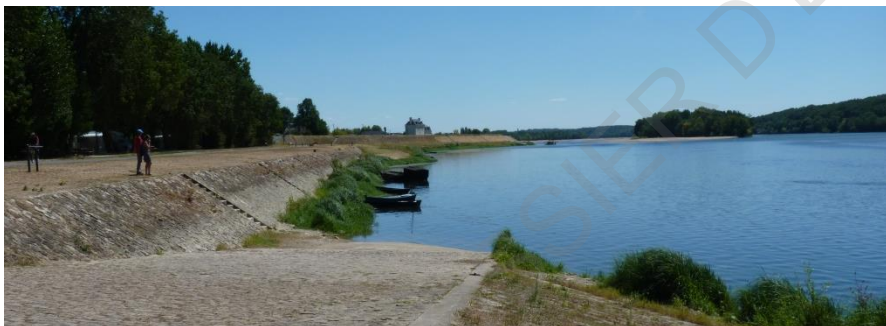
Figure 28 : Quai des bords de Loire à La Ménittré (source : EVEN Conseil).
