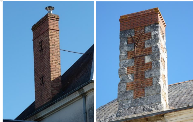
Figure 22 : Cheminée en tuiles sur une maison à Noyant / Fontaine-Guérin (source : EVEN Conseil).
